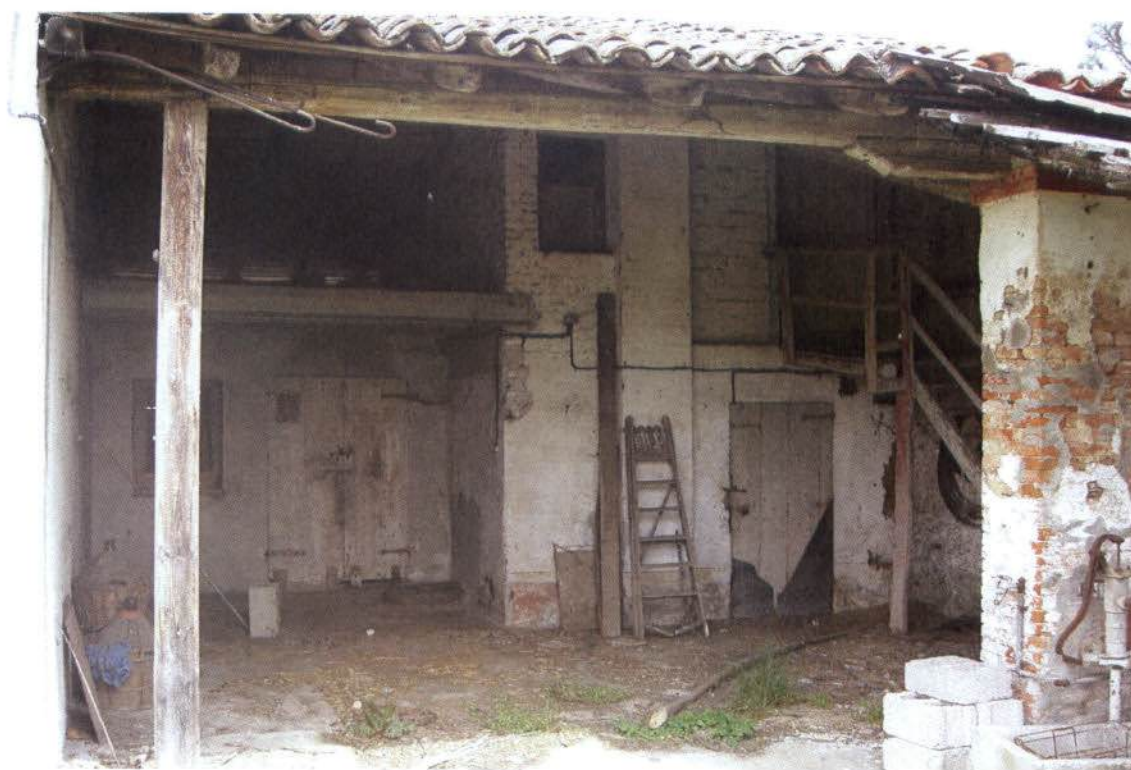
FOTO 3- Ex stalla, fienile e magazzino
